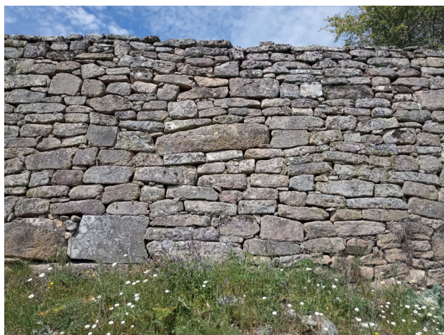
Figura 7. Ejemplos del aparejo de la muralla de Yecla la Vieja. Fotografías del autor.
